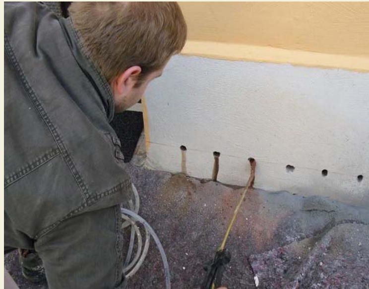
Bohrlöcher mit Wasser ausspülen
